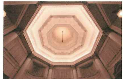
展示室からみたドーム屋根の内側
