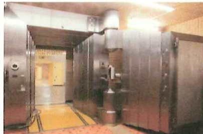
地下金庫の扉
